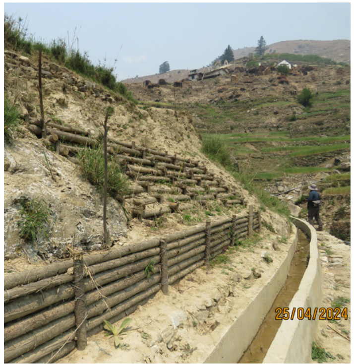
तहगत बायोइन्जिनियरिङ प्रविधि: नेपालको जुम्लामा कृषि भूमिलाई क्षयिकरणबाट बचाउन निर्माण गरिएको काठको क्रिब पर्खाल र चेक बाँध । (तस्बिर: RECOFTC नेपाल, सन् २०२४)
